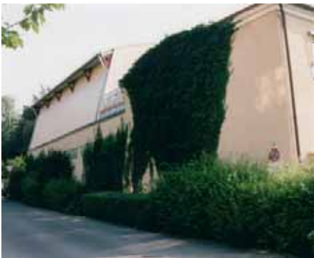
Gebäudekomplex, Alpenstr. 48 Ansicht Westseite
