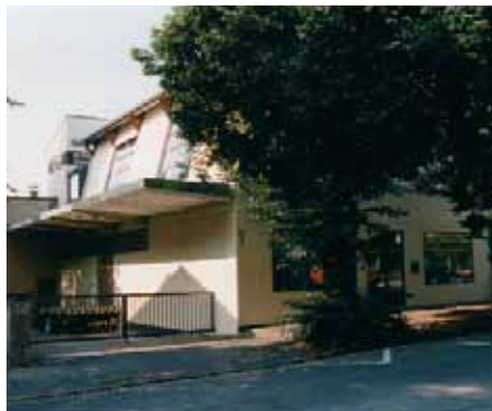
Ansicht Ostseite mit Verladerampe für LKW
